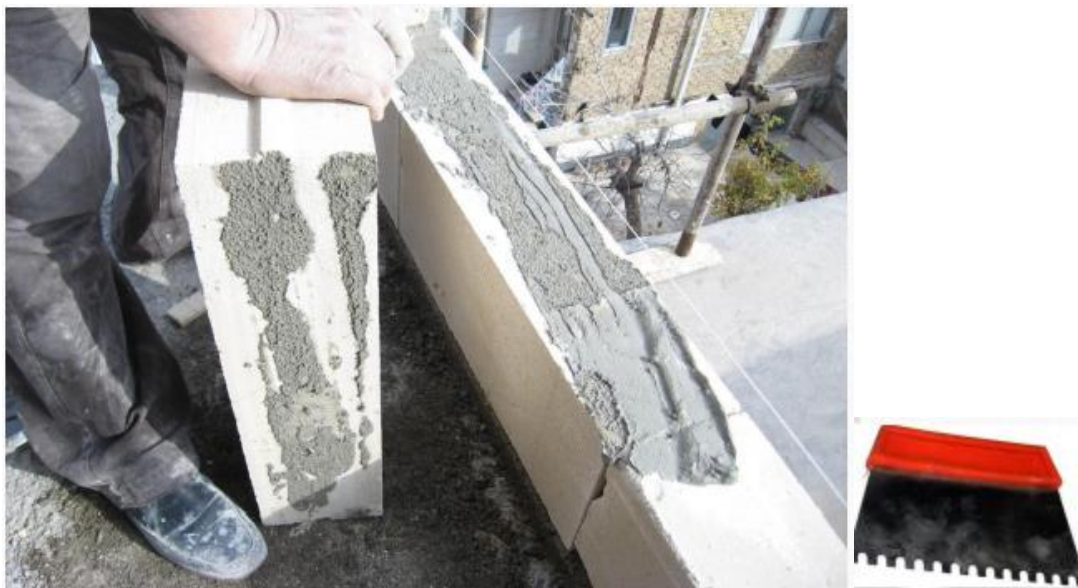
شکل ۶۷- توزیع غیر یکنواخت و عدم پوشش کل سطح از چسب پیرین
