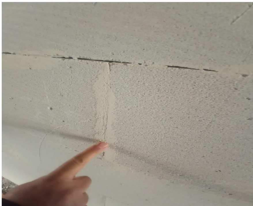
شکل ۳۵- درزگیری بلوک های پرین
