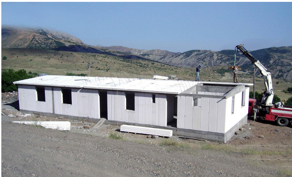
شکل ۳۱- نمونه ساختمان در حال اجرا با بلوک های مسلح پرین (سقف)
