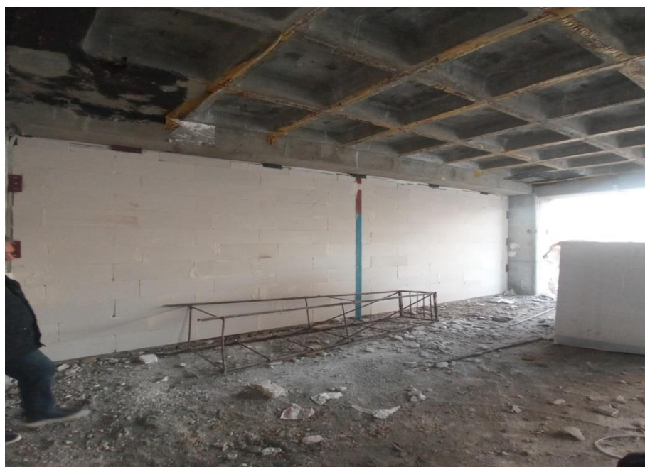
شکل ۳۳- نمایی از دیوار اجرا شده با بلوک های پرین
