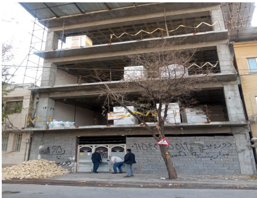
شکل ۳۲- نمایی از ساختمان بازدید شده
