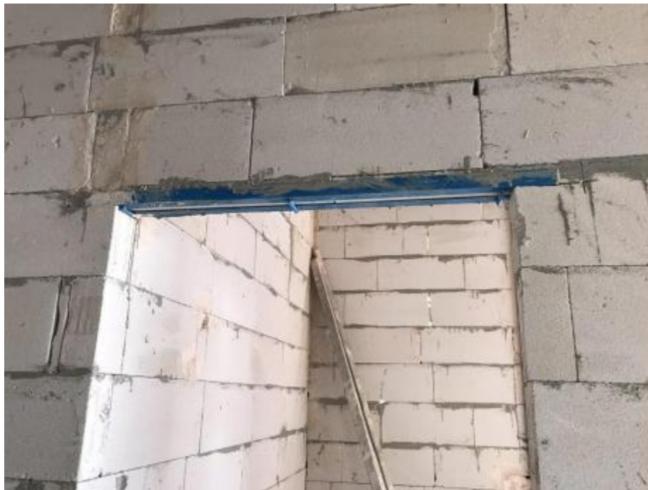
شکل ۷۱- عدم رعایت نشیمن نعل
