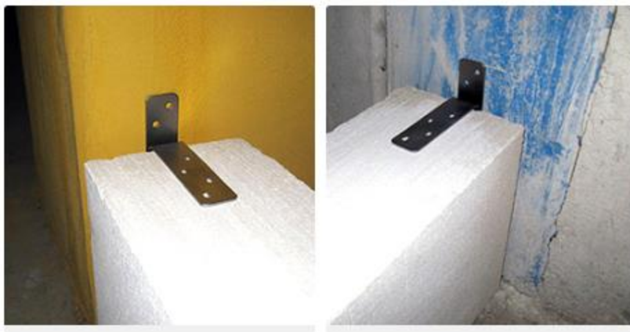
شکل ۹۴- اتصال بلوک به ستون
