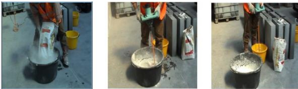
شکل ۹۸- سمت چپ: اضافه کردن چسب به آب، وسط: استفاده از مخلوطکن مکانیکی برای اختلاط آب و ملات، سمت راست: استفاده از یک سطل کوچک آب برای شستن تیغه مخلوطکن
