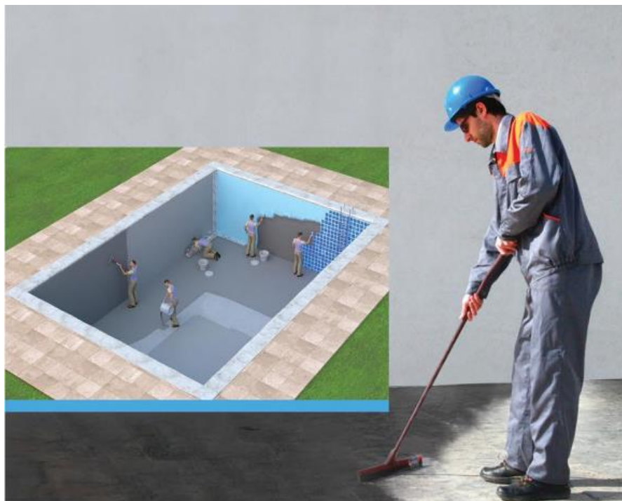
شکل ۵۸- نمونه اجرای عایق رطوبتی پرین
