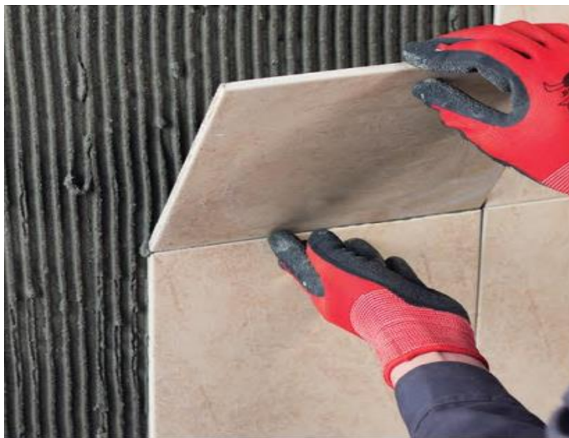
شکل ۴۵- اجرای چسب کاشی و سرامیک پرین
