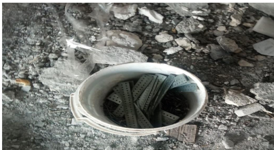
شکل ۳۹- بست های به منظور اتصال بلوک های پرین
