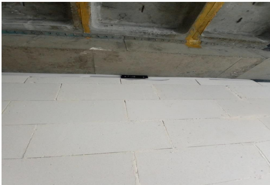
شکل ۳۶- نبشی های متصل به بالای دیوار اجرا شده با بلوک پرین
