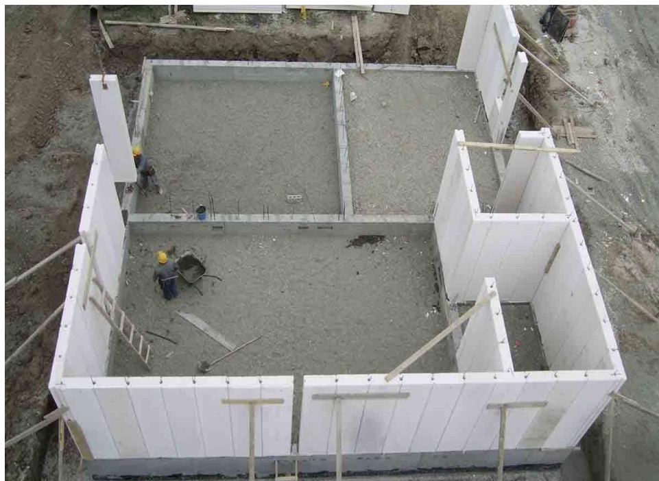
شکل ۳۰- نمونه ساختمان در حال اجرا با بلوک‌های مسلح پرین (دیوارها)
