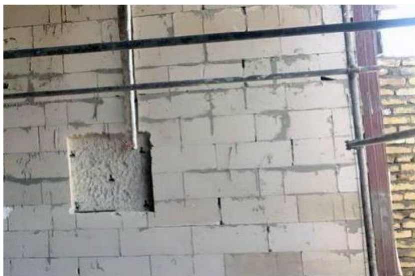
شکل ۷۶- اجرای شیارهای عمیق دیوار فاقد تقویت
