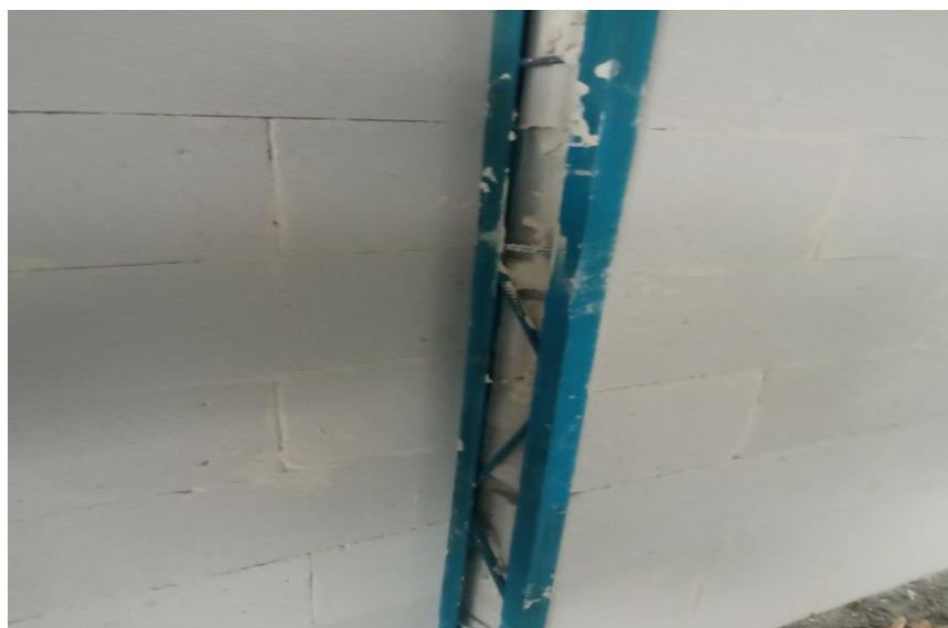
شکل ۳۷- نمونه اجرای وال پست
