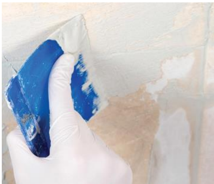
شکل ۴۸- اجرای گروت درزبندی کاشی و سرامیک پرین
