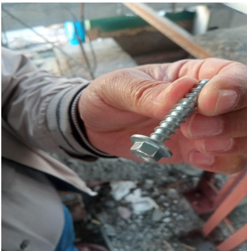
شکل ۴۰- پیچ های جهت اتصال U شکل به ستون
